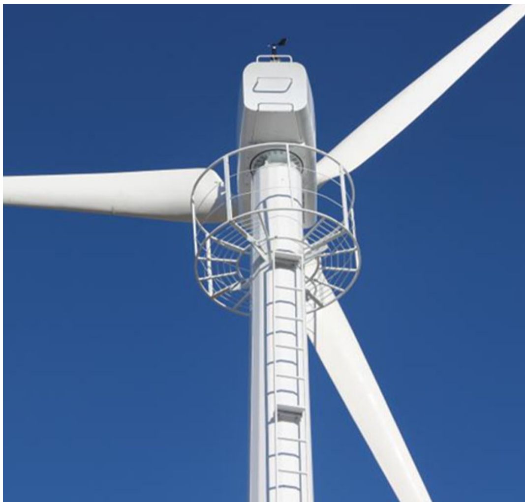
Рис. 1. Ветроэнергетическая установка мощностью 2,5 МВт.
